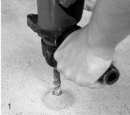
Fig. 5 Pritrditev vložka vrtalne stojke v beton z zabijalnim sidrom
