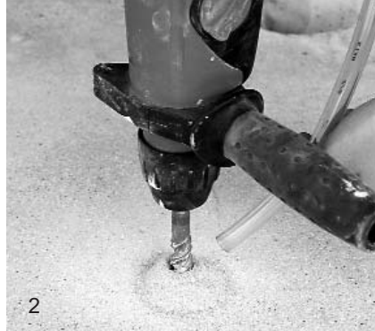
Fig. 5 Pritrditev vložka vrtalne stojke v beton z zabijalnim sidrom
