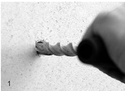
Fig. 6 Pritrditev vložka vrtalne stojke v zid z razcepnim sidrom (sidrni vložki)
